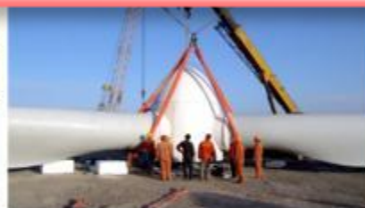
800KW竹制 风电叶片安装
